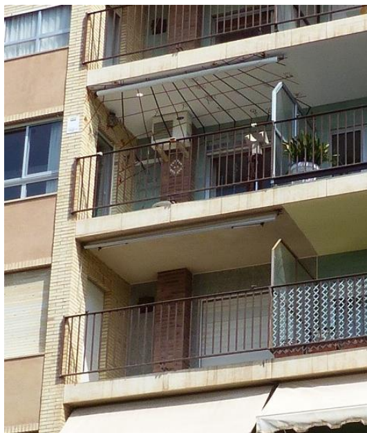
4階テラス部分外観拡大
