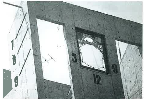
18. 名古屋、サンダイアル・マンション。マンションが北面しているので、南からの透過光を利用できるように透明にした。東西面は左右の壁面。1985年？
