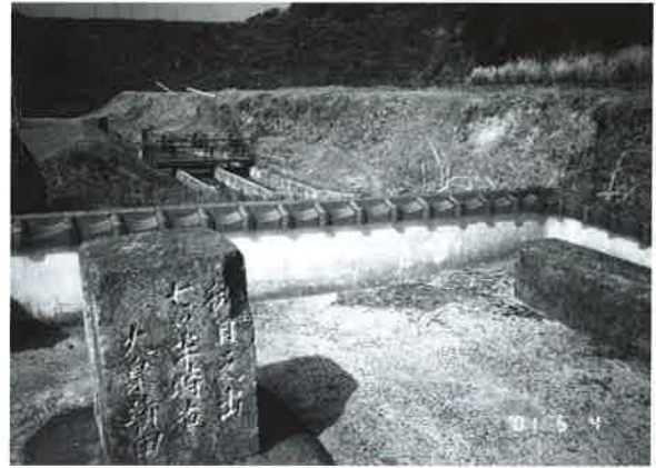
写真 4. 上方は笠田大溜の堰堤、その下は現在の水門 ここから用水が三つに分岐している。
