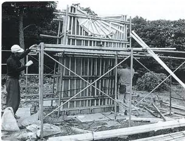
写真3 コンクリート注入後
