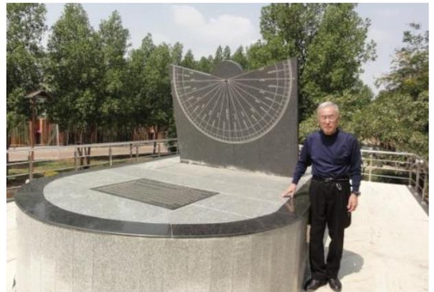
日時計は公園の入り口を入ったところであり、高さ約3mの大きな立派な高台の上に設置してある。ネズミ色の厚さ約8cmの黒大理石の板の両側に時刻盤が詳しく刻んである。日時計の大きさは時刻盤の直径が約2mのコマ型日時計である。日時計の乗っている台に均時差の表も付いている。説明板も別に1畳敷ほどのものが高台の側面に英語とタミール語で記してある。設計はハリプラサド(Pidaparty Purna Satya Hariprasad)で設置は2012年12月である。シルパラマはマドハプール(Madhapur)にあるハイ・テクの町である。
